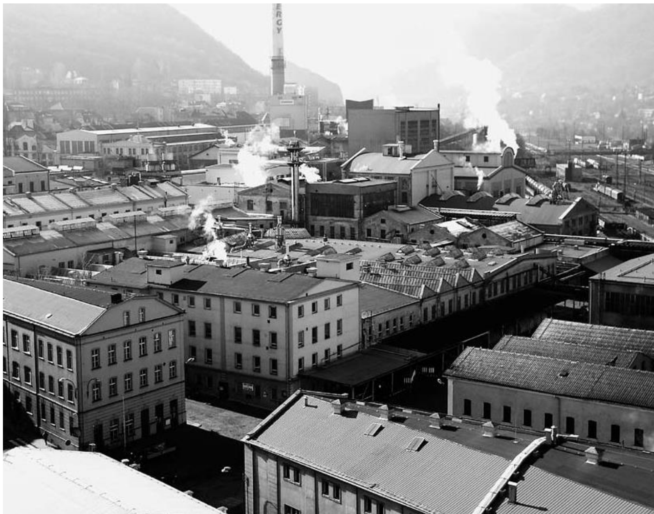
Východní část areálu, mydlárna, 2006, archiv společnosti Setuza.
